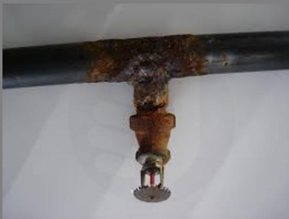
Protección de caños contra corrosión externa
