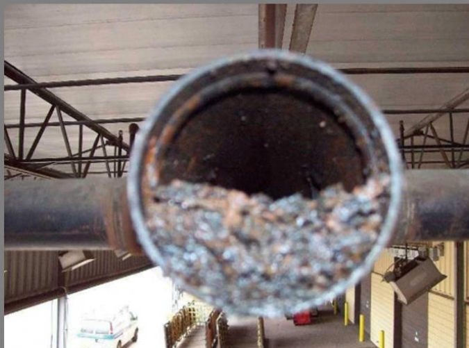
Protección de caños contra corrosión externa
